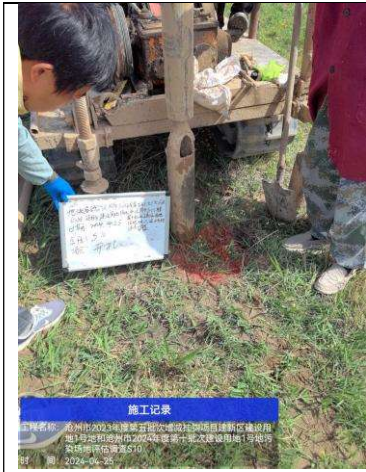
施工记录 工程名称: 沧州市2023年度第五批次增减挂钩项目建新区建设用 地1号地和沧州市2024年度第十批次建设用地1号地污 染地块评估调查S10 时 间: 2024-04-25
