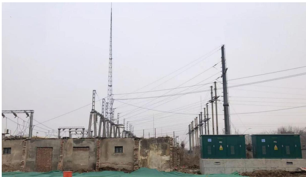
图3.3-2 现场踏勘时变电站
